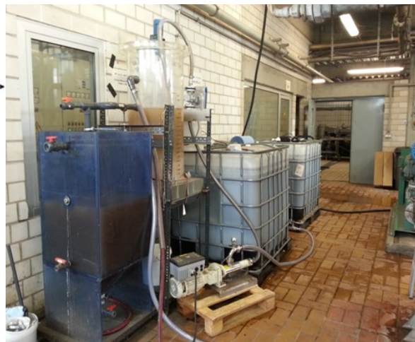
Abb. 8: Bildliche Darstellung der Halbtechnikanlage
