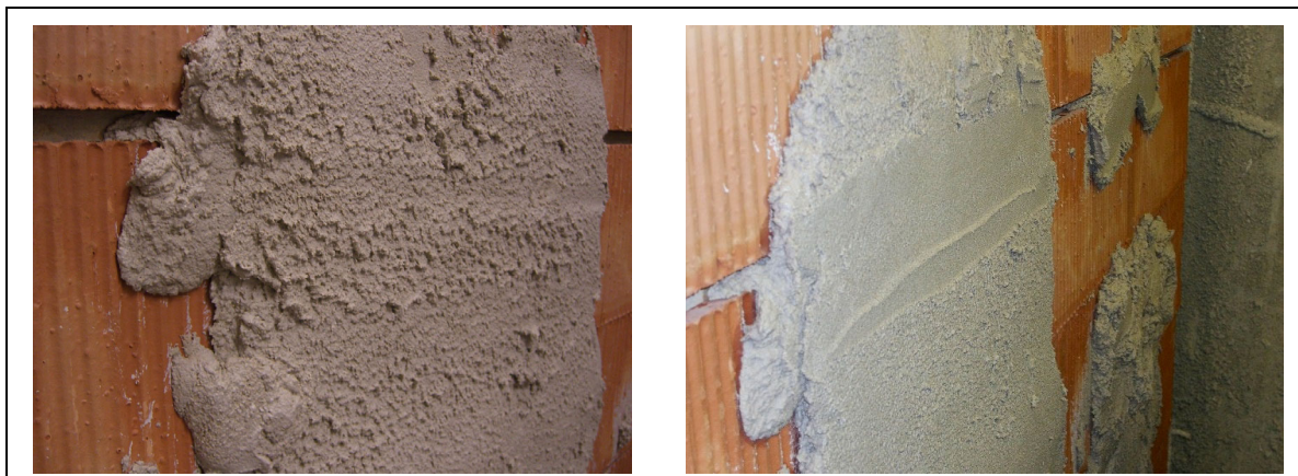
Abb. 5.98: Mörtel aus tKH 3 nach Abziehen
