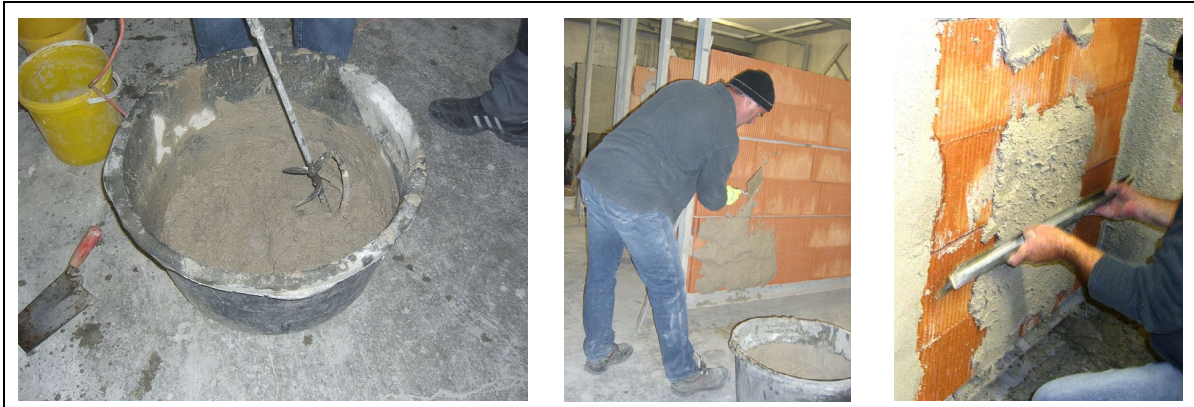
Abb. 5.93: Anmischen, Aufbringen und Abziehen der Mörtelmischungen per Hand
