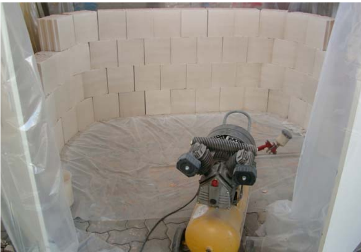
Bild 19: Vorbereitung der Putzflächen der SX+ mit Kaolin
