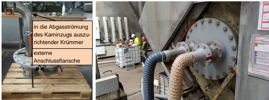
Abb. 25: Abgasrohre auf Flansch DN 600, links: vor Versand, rechts: in Kamin eingebaut
