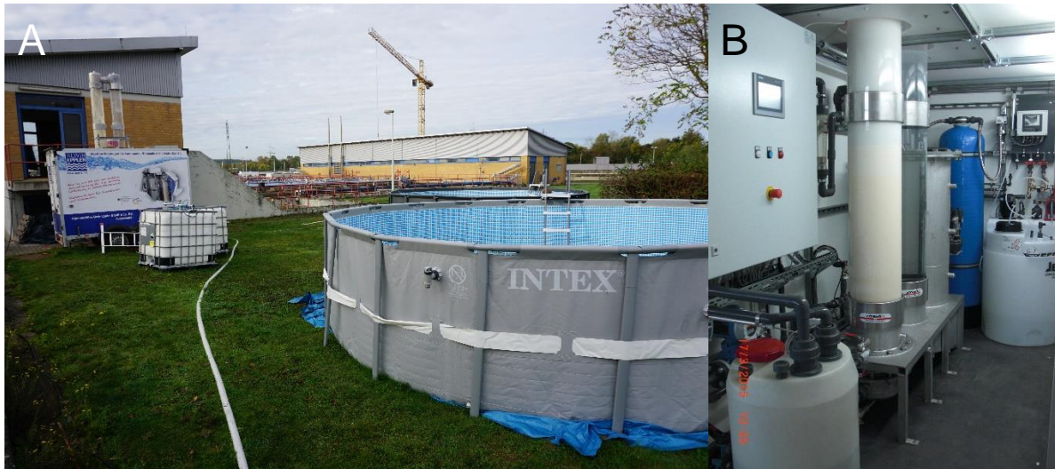
Abbildung 8: A) Pelletreaktor inklusive Vorlagebecken. B) Pelletreaktor von innen.
