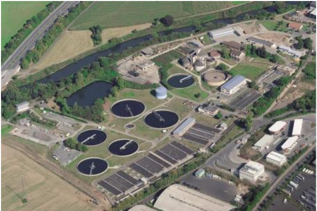
Abbildung 4: Luftbild der Kläranlage Gießen
