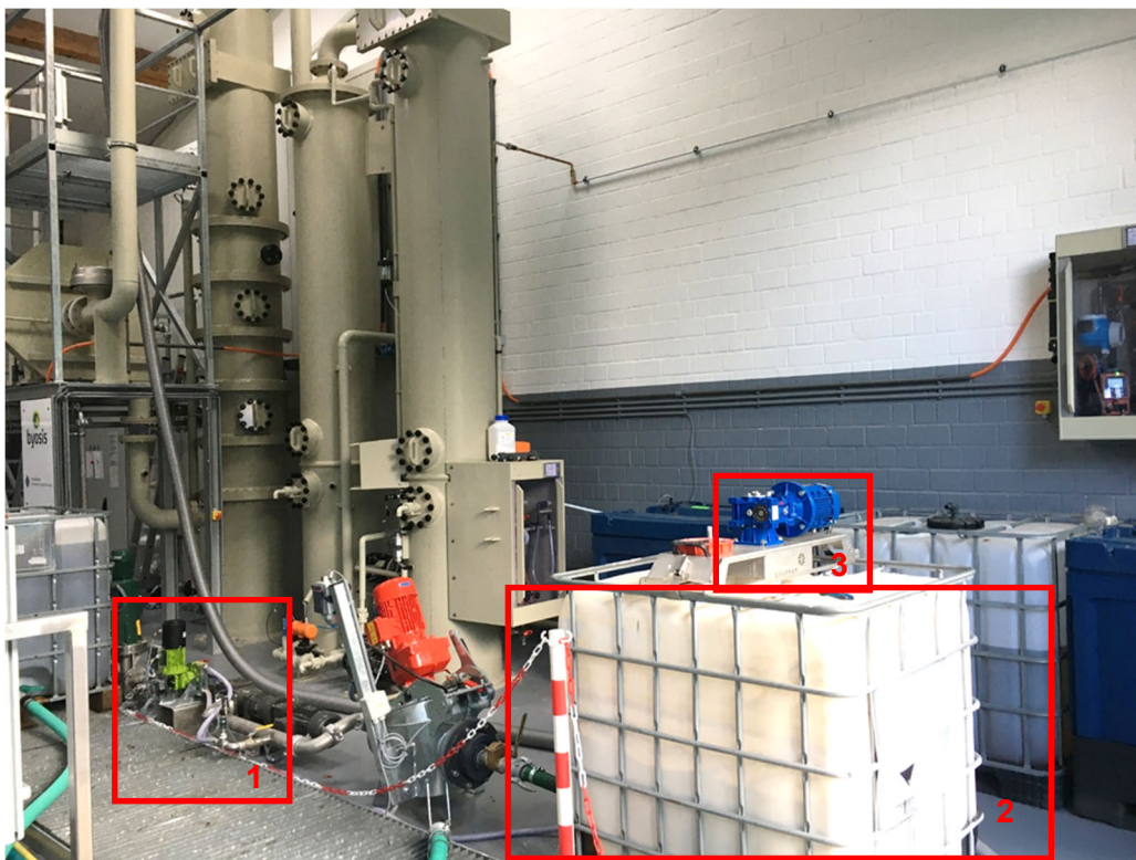
Abbildung 3-5: Kalkmilchdosierung (1), Kalkmilch (2) und IBC-Rührer (3)
