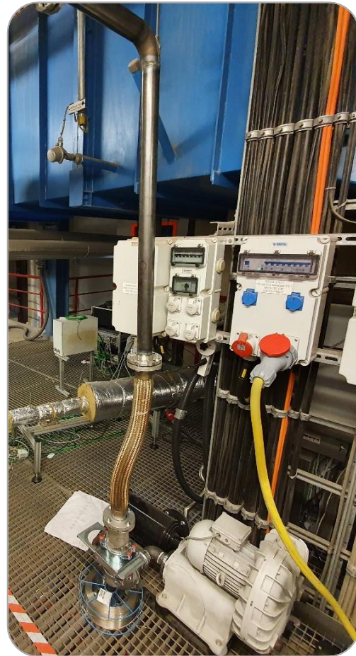
Abbildung 5.7: Gewebefilter, Volumenstrommessung und Gaskühlung/Kondensator (links), Saugzug und Leitung zur Rückführung der Rauchgase in den Kessel 2 (rechts).
